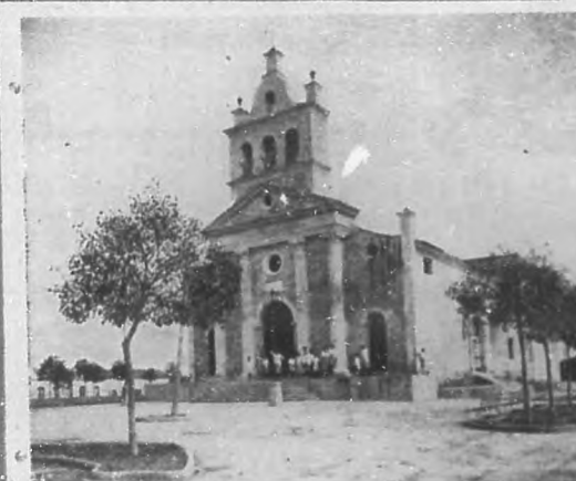
UNA OBRA DEL PADRE CONYEDO.—El benefactor Conyedo, insustituible constructor de obras en las Villas, perpetuó su memoria con el templo de El Carmen.
